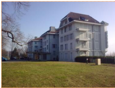
Bâtiment A à rénover
