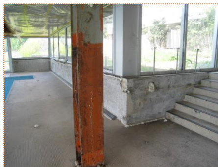
Piscine : Après désamiantage : retrait de la faïence blanche)
